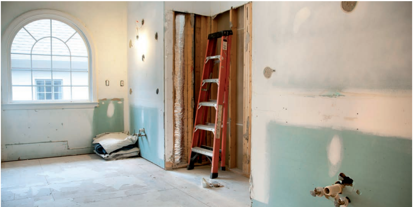
Leistungen, die der Erhaltung und Instandsetzung von Bauwerken dienen wie z.B. Renovierungs- und Installationsarbeiten, unterliegen der Bauabzugsteuer.
